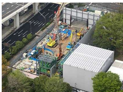
神奈川公園発進立坑全景
