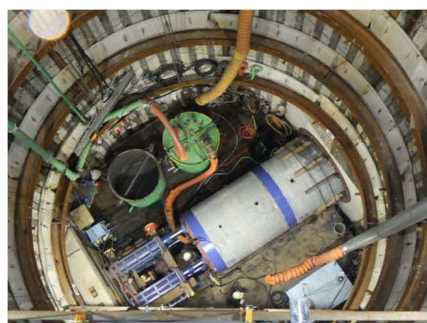
和泉町第二公園立坑
