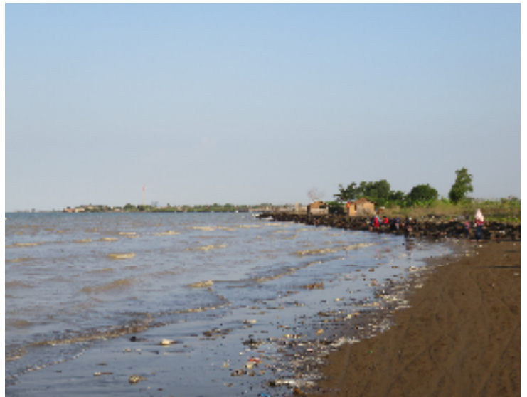
パティンバン新港建設予定地と推測される海岸地区 (写真: 弊社社員提供)
