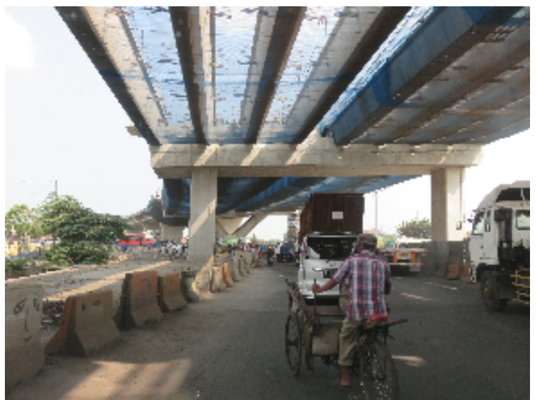
建設工事中のタンジュンプリオク港へのアクセス道
