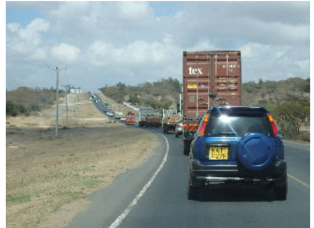
片側1車線の直線道路のため渋滞しやすい
