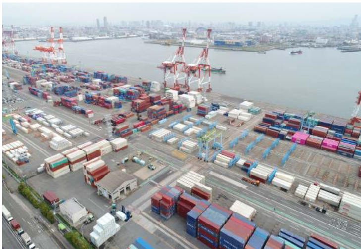
【写真:ドローン空撮】
