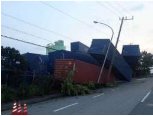
千葉中央ふ頭コンテナターミナル 空コンテナ倒壊
