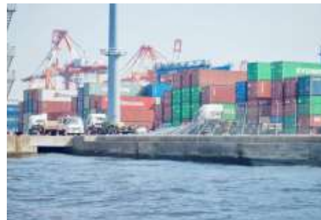
本牧埠頭 コンテナヤード付近フェンスの倒壊
