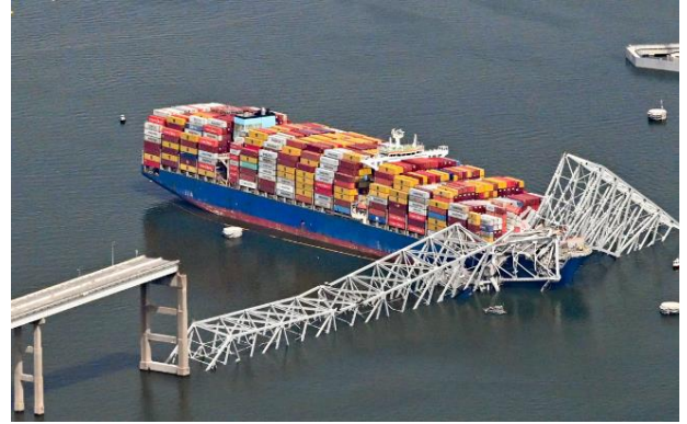
崩落したフランシス・スコット・キー橋の様子
